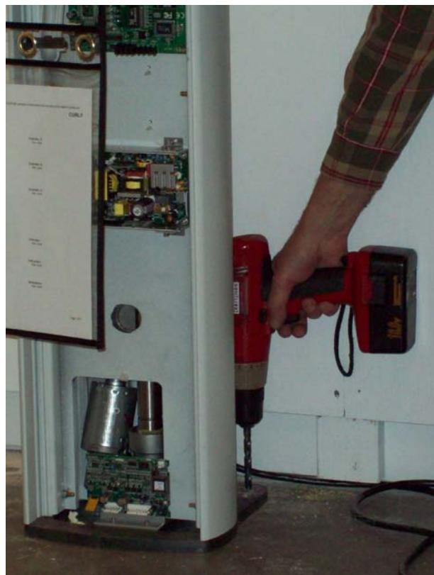
3. Otvorem v podstavě vložte kotevní úchyt do cementu. Na úchyt do cementu sestavte matku a podložku a utáhněte. Dbejte, aby bylo kotvení v otvoru dokonale usazeno. V případě dřevěné podlahy sesaďte vrut s podložkou a vložte je otvorem v podstavě. Nástrčkovým klíčem vrut částečně zašroubujte.
